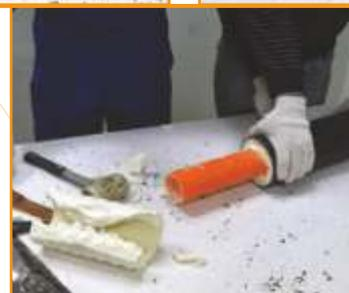
**5** Выровнять торец напорной трубы ИЗОЛА.ПРО с помощью трубореза (обрезать перпендикулярно оси трубы).
