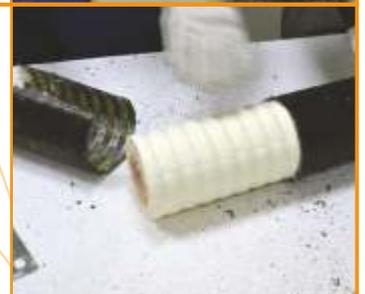
**4** Отбить молотком теплоизоляцию с конца трубы.
