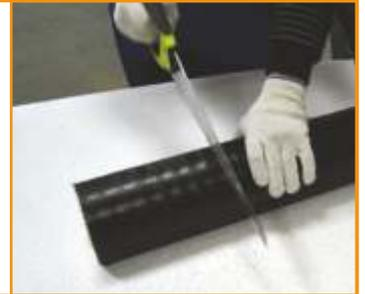
**2** Пилой или ножом разрезать защитную оболочку от торца трубы до поперечного надреза.
