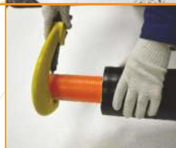
**6** Надеть монтажную гильзу на напорную трубу ИЗОЛА.ПРО.
