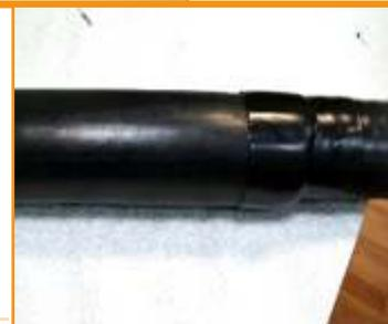
**16** При помощи рулетки отметить центр термомуфты, и перьевым сверлом [D=20 мм] просверлить отверстие для заливки изолирующего слоя ППУ.
