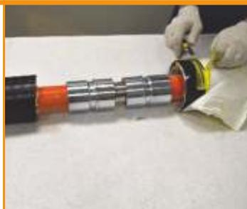
**14** Отцентрировать термомуфту по середине стыка, так чтобы оболочка трубы выходила за концы термомуфты на 15-20 мм.
