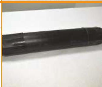
**15** Удалить упаковочную пленку с поверхности термоусаживаемой ленты. С помощью строительного фена разогреть термоусаживаемую ленту и проклеить стыки термомуфты и защитной оболочки трубы ИЗОЛА.ПРО. (выполнить с двух сторон).
