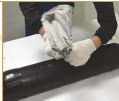
**19** Извлечь пробку для стравливания воздуха. Вставить заглушку и с помощью строительного фена заплавить отверстие. Выступающие части заглушки удалить с помощью ножа.
