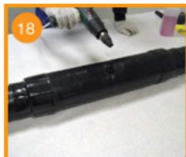
10. Удалить защитную бумажную упаковку с поверхности термоусаживаемой муфты. Размеры муфты указаны в таблице.
