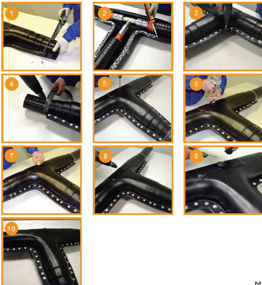
1. Подготовить к работе кожух для изоляции тройникового соединения. Размеры кожухов (КИТ) представлены в таблице 9.4. Концы защитного тройникового кожуха отпилить под необходимый наружный диаметр защитной оболочки. **ВНИМАНИЕ!** Кожух должен прилегать к ПЭ-оболочке труб не менее 15-20 мм с каждой стороны.
