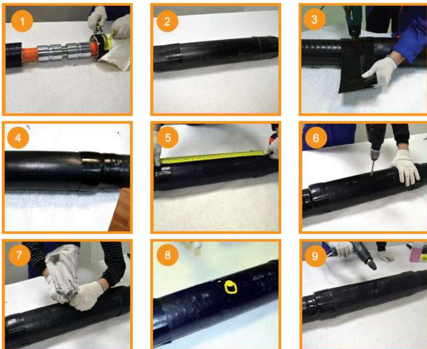
1. Перед началом монтажа стыкового соединения надеть термоусаживаемую муфту на один из соединяемых отрезков трубы.
