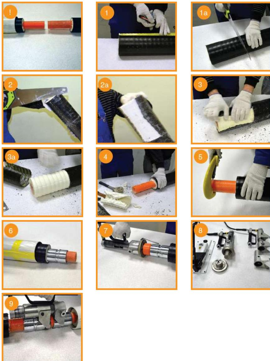
**ВНИМАНИЕ!** Перед началом монтажа пресс-муфты необходимо надеть термоусадочную муфту на поверхность трубы ИЗОЛА.ПРО, предварительно поверхность трубы предварительно очищается от загрязнения!
